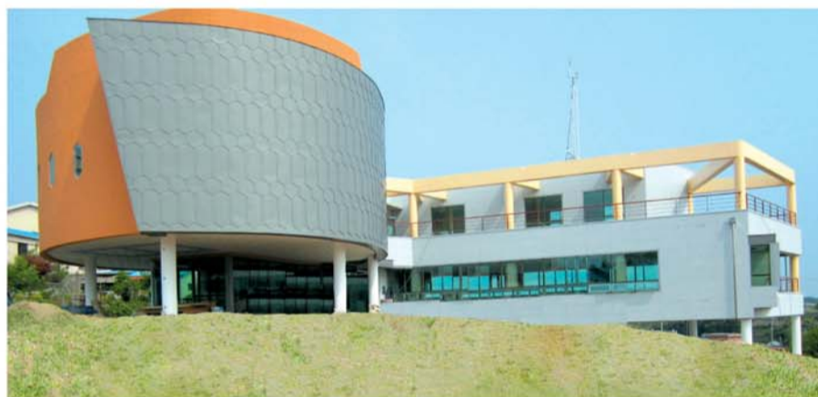
내달 준공 예정인 서포면 신청사 전경.
