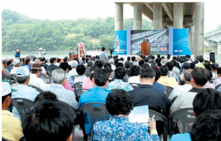
사천 흥사일반산업단지 진입도로 쓰일 사천시 축동면 가산리~곤양면 흥사리 도로 확포장 및 교량 가설공사 기공식이 지난달 13일 열렸다.
