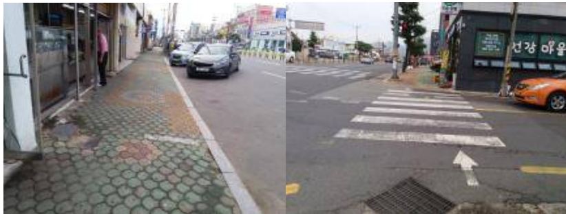
〈 조사구간 전경 〉 〈 보도상 불법 적재물 및 불법주차 〉
