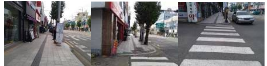
〈불법 적치물〉 〈보도 관리 미흡〉 〈보행 단절 안전시설 미설치〉
