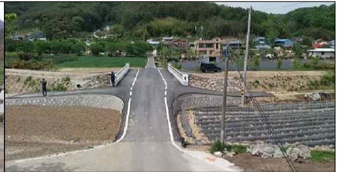
무고천 맥사 소교량(정비 후)
