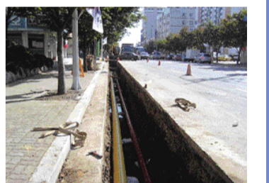
용강현대아파트와 도시가스 배관공사 현장
